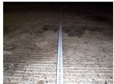
写真-2 舗装切削
