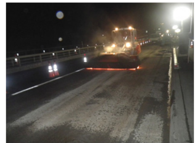
写真-1 夜間施工
