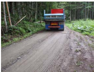
チップ詰め麻袋設置 後、走行試験
