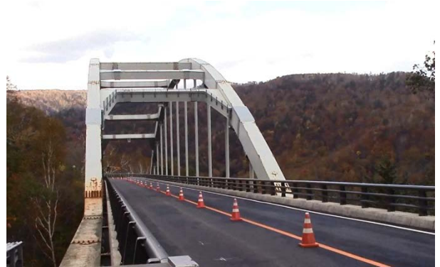
写真-1 対象橋梁全景
