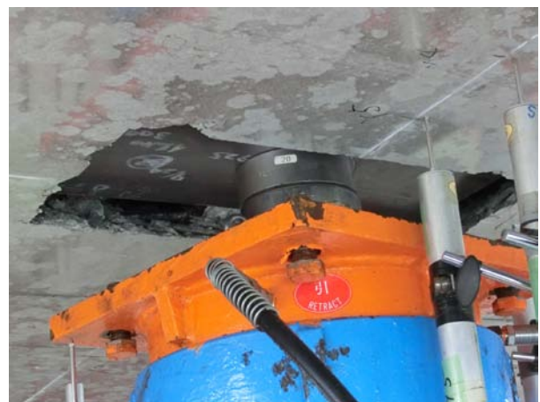
図-11 荷重板の押し抜き状況
