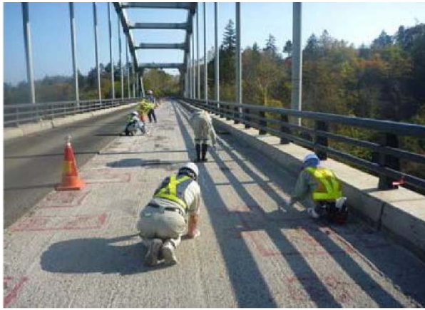
写真-3 実橋における試験状況
