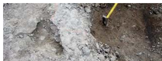
d) 浮き部の周波数分析結果と上面はつり後の状況
