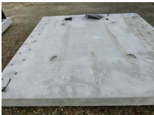
写真-1 供試体全景（健全部）
