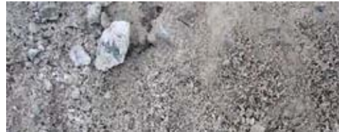
b) 砂利化部の周波数分析結果と上面はつり後の状況
