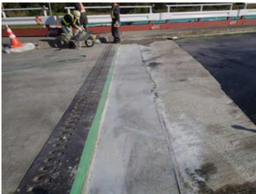
写真-3 補修後状況 (A1側)
