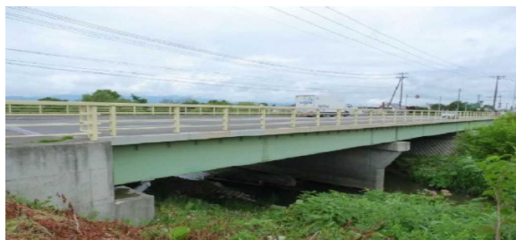
写真-1 橋梁側面全景
